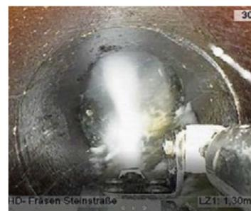
Auf dem Foto aus dem Kanal deutlich zu sehen: der weiße Wasserstrahl in der Mitte. Mit einem Druck von 2.000 bar entfernte der Fräsroboter 95 Prozent des Betons.
