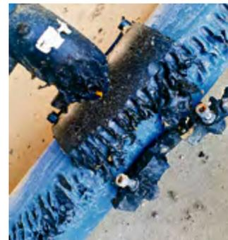
**Die Arbeiten zum Breitbandausbau führten zu diesen Schäden an der Wasserleitung.**
