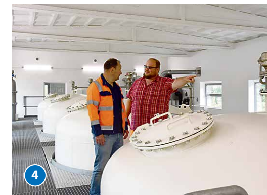
Die Filtration – Reinheit durch Quarzsand: An dem Querschnitt durch einen Filter (Foto 3) erkennen Besucher gut, wie das Rohwasser aus den Brunnen den Quarzsand in den Filterbehältern durchströmt. Dabei bleiben Eisen- und Manganoxide sowie weitere Trübstoffe im Filter zurück. Die Filterkessel (Foto 4) werden in der Hochsaison zweimal wöchentlich gespült.
