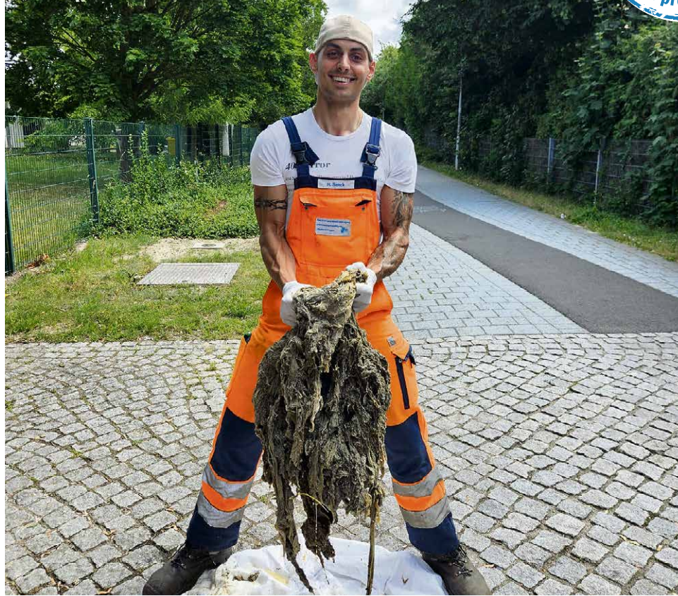
Fritz Hubert Seeck zeigt eine Verzapfungen aus dem Pumpwerk Backofentrift. Das bringt jede Technik zum Stillstand.
