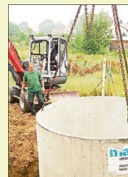
Einbau einer zertifizierten (also dichten) Sammelgrube.
