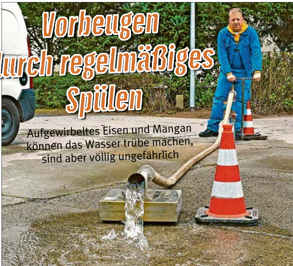
Mitarbeiter Paul Räsch lässt das kühle Nass rauschen, um so das Trinkwasserrohrnetz zu reinigen.
