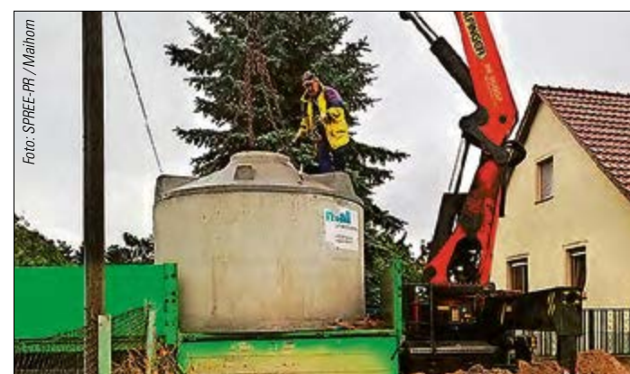
Einbau genehmigt? – Na dann runter mit der Sammelgrube!
