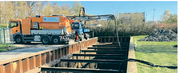
Das Regenrückhaltebecken in der Bahnhofstraße wurde turnusmäßig gereinigt – in Eigenleistung. Der angesammelte Sand ging zur Sandwaschanlage auf der Kläranlage. Das Becken fasst wieder volle Kapazität. Gleichzeitig bereitet die Maßnahme eine Investition vor, die den Niederschlagswasserabfluss bei Starkregen verbessern soll.
