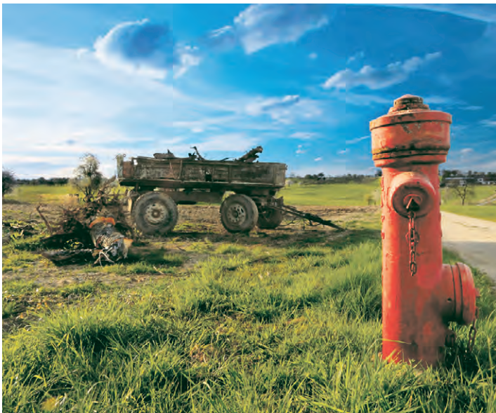
Ein Hydrant am Wegesrand: Wo das Trinkwassernetz endet, endet auch die Zuständigkeit des Zweckverbands – Löschwasser ist Aufgabe der Gemeinden.
