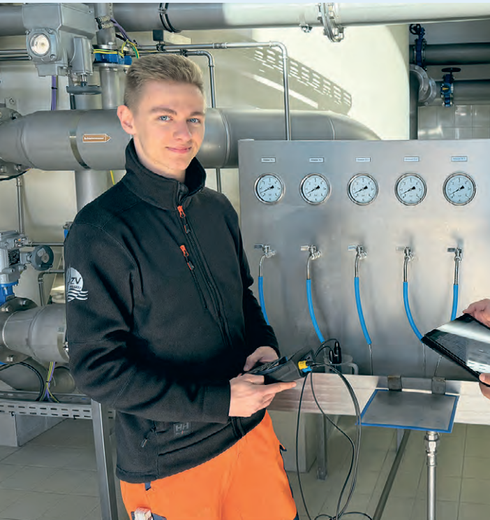
Auszubildender Benjamin Holznagel misst den pH-Wert des Reinwassers direkt im Wasserwerk.
