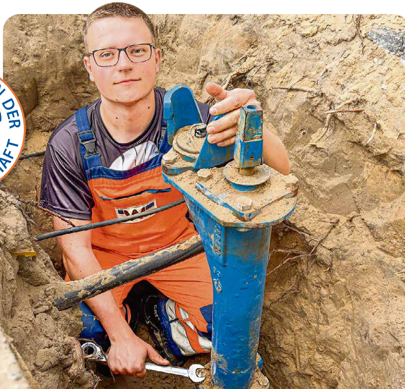
Am liebsten arbeitet Lowis Lindemann im Bereich Rohrnetz. „Die Arbeit an den Anlagen – so wie hier, an einem Hydranten – macht mir großen Spaß.“ Wenn er seine Prüfung besteht, wird er das Team des Zweckverbands dort als Fachkraft verstärken.
